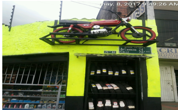
Foto No. 4: ELEMENTO NO AUTORIZADO ADOSADO A LA FACHADA DEL ESTABLECIMIENTO
